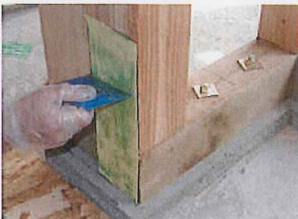
7.接着剤の含浸 ヘラで上下方向にしごく(軽いたたくと下塗剤がシート上へ染み込んでくる)
