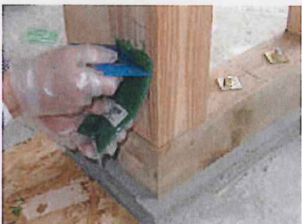
4.接着剤の下塗り-1 シートの貼る長さを墨出しし、ヘラで接着剤を少量ずつ木部面に塗布する
