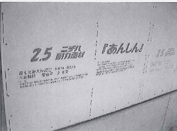
施工状態 近景
