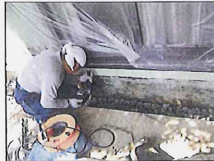
3. あと施工アンカー 掘削孔
