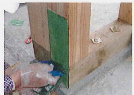
9.接着剤の上塗り-2 ヘラで接着剤をのぼし、シートへ含浸させる
