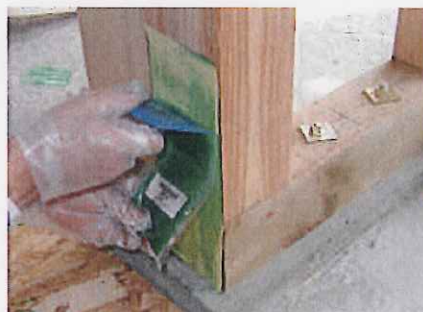
8.接着剤の上塗り-1 ヘラで接着剤を少量ずつシート面に塗布する
