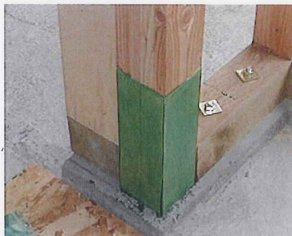
8.接着剤の上塗り-1 ヘラで接着剤を少量ずつシート面に塗布する
