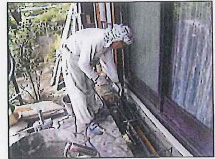
6. コンクリート打設
