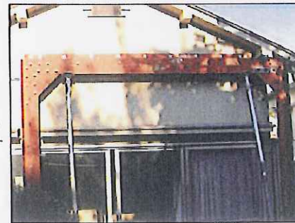
4. ガンコモンG2上部 鉄骨フレーム取付 モルタル外壁の上 からコーチボルト で梁に緊結。 LアングルをH.T.B. で組立、鉄骨フレー ムを造る。
