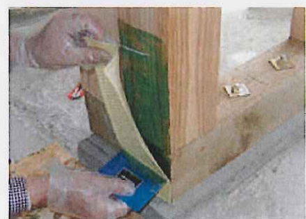
6.シート接着 シートの片側をヘラで固定しながらのぼす
