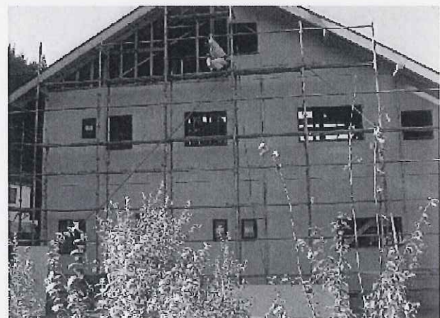
施工状態 遠景
