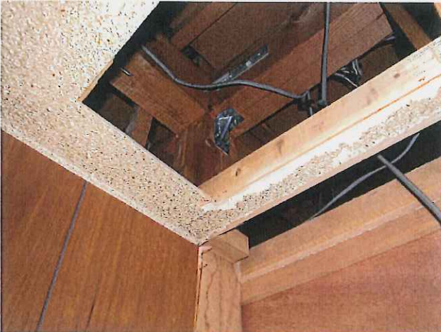
金物を付けにくい場合、天井部分撤去
