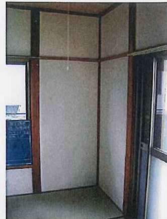
1. 内壁施行 現況
